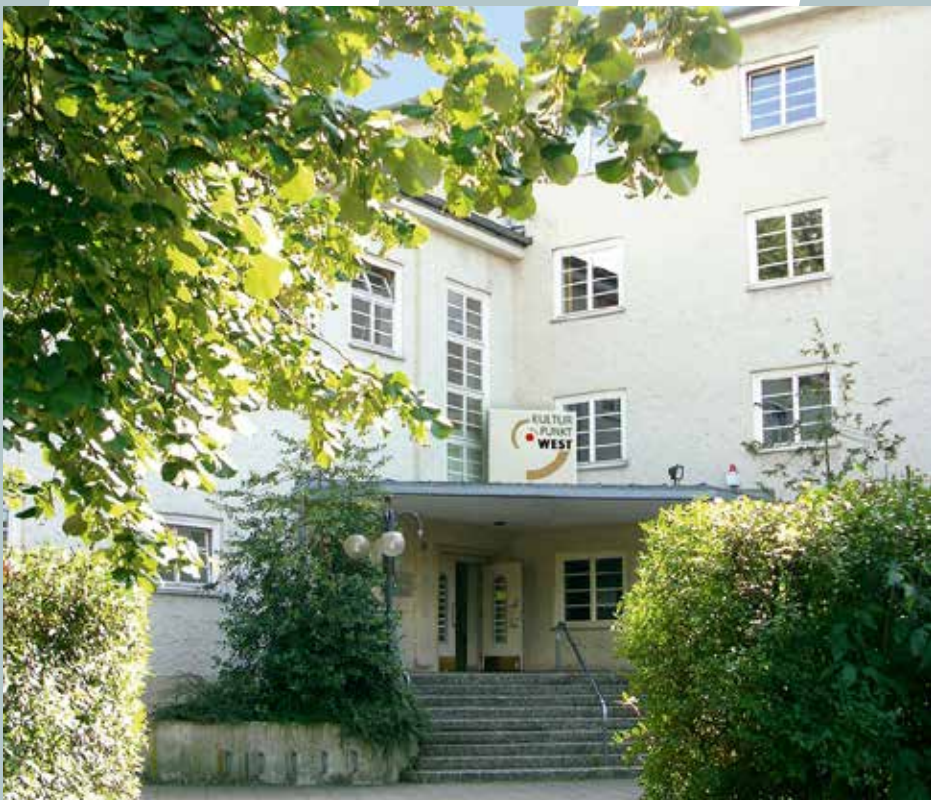
Die Sanierung des Hauses beginnt erst im Sommer – Stockwerk für Stockwerk, so dass das Programm im Kulturpunkt West weiterlaufen kann.
