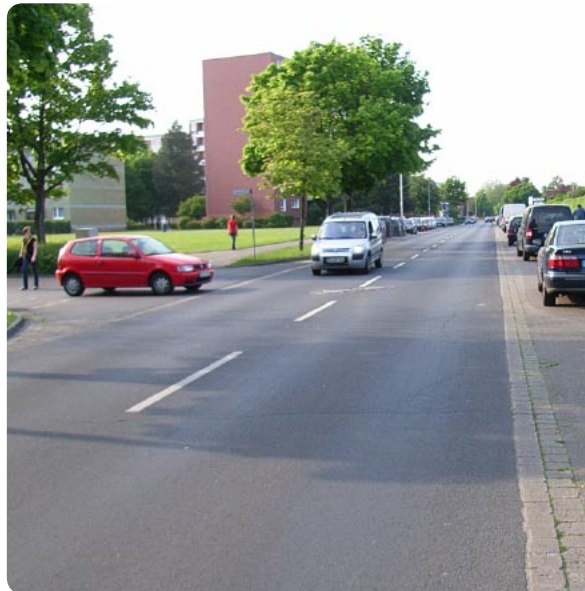
Einmündung Havelstraße vorher, Blickrichtung Norden
