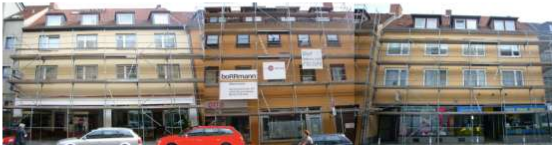
Eingerüstete Fassaden in der Sonnenstraße
