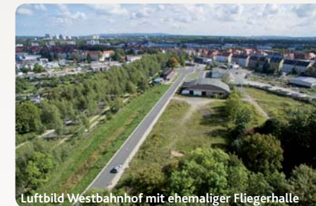
Luftbild Westbahnhof mit ehemaliger Fliegerhalle
