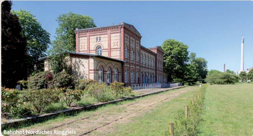
Bahnhof Nördliches Ringgleis
