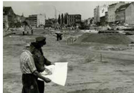
Bauarbeiten am Augusttorplatz 1960 (Stadtarchiv Braunschweig, H XVI: A VII)
