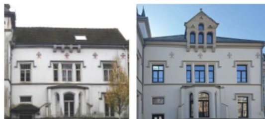
Rekonstruktion der Gaube
