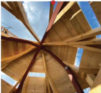
AUSBAU DES TURMS
