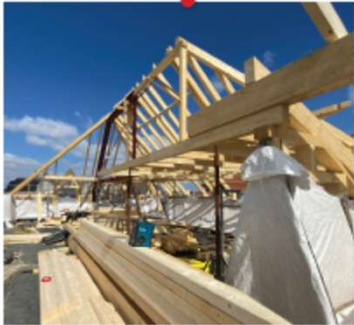
RICHTEN DES DACHSTUHL
