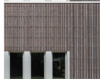
Fassade des dreigeschossigen Büro- und Laborgebäudes.
