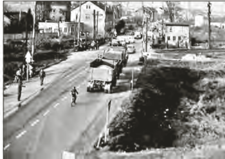
Bild 1: Bahnübergang Frankfurter Straße von Süden.
