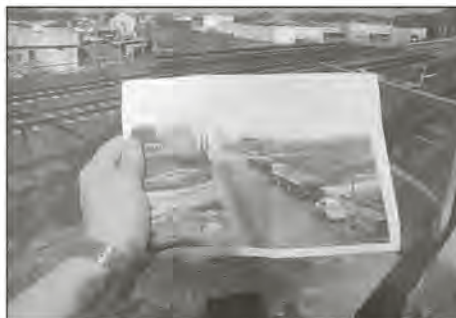
Bild 2: Der Bahnübergang 1950 und 2010 von erhöhter Position aus.
