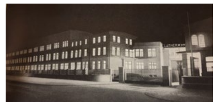
Luther-Werke, Straßenansicht bei Nacht
