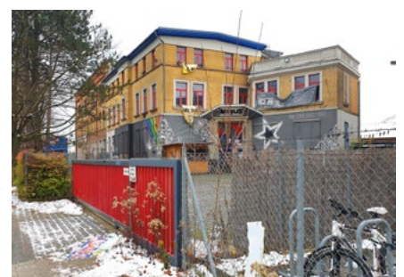
Das Nexus ist im früheren Verwaltungsgebäude der Luther-Werke beheimatet. In einem Probenraum steht in einer Nische das beschriebene Radialgebläse
