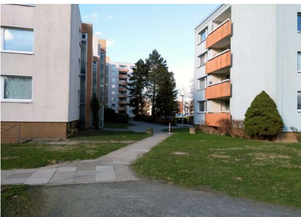
Abbildung 14: Sanierung des Bestandes Wipperstraße (Quelle: Stadt Braunschweig)
