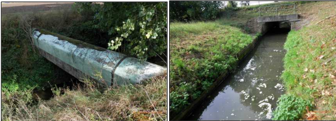
Abbildung 3: Planerische Zwangspunkte (Durchlass B214, Rohrbrücken)
