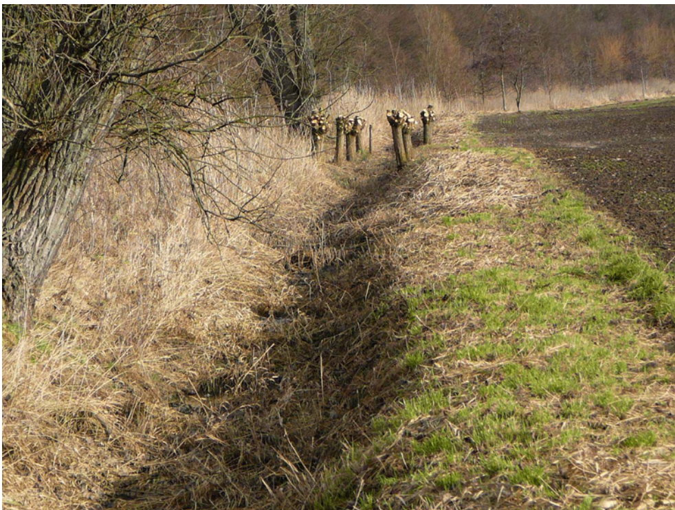
Abbildung 5: Blick aufwärts in den als Altarm fungierenden alten Bachverlauf
