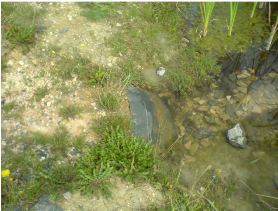
Abbildung IV: Einlauf Regenwasser mit Teichfolie
