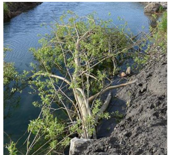
Abbildung 6-14: Raubbaum nach Einbau
