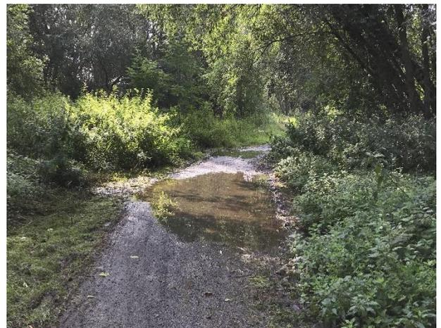
Abbildung 6-4: Weg am linken Ufer entgegen Fließrichtung Schottertragschicht aufgefüllt. Auf dem neu hergestellten Planum wird der Wegeaufbau mittels des seitlich lagernden Aushubs und weiteren zu liefernden Mengen hergestellt. Die Wegebreite wird zusätzlich von derzeit ca. 1,2 m auf 1,5 m vergrößert und passt sich somit in den anschließenden Bestand ein. Dabei wird die Oberkante (68,55 m NHN) mit leichtem Gefälle 2 % zur Schunter hin ausgeführt, um eine zügige Entwässerung zu gewährleisten.
