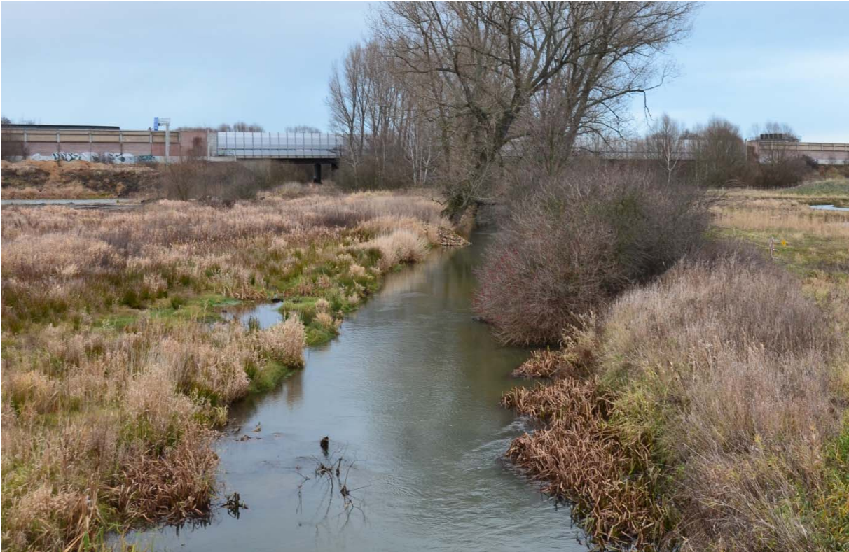
Abb. 11: Profilaufweitung bis MW im Uferbereich der Schunter unterhalb der BAB 2 (Foto: M. Lehmann).
