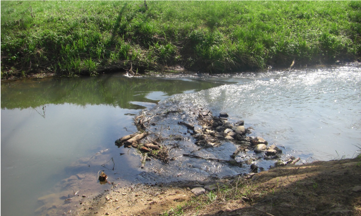
Abb. 7: Eingebauter Strömungsenker aus geschütteten Steinen (Foto: M. Lehmann).
