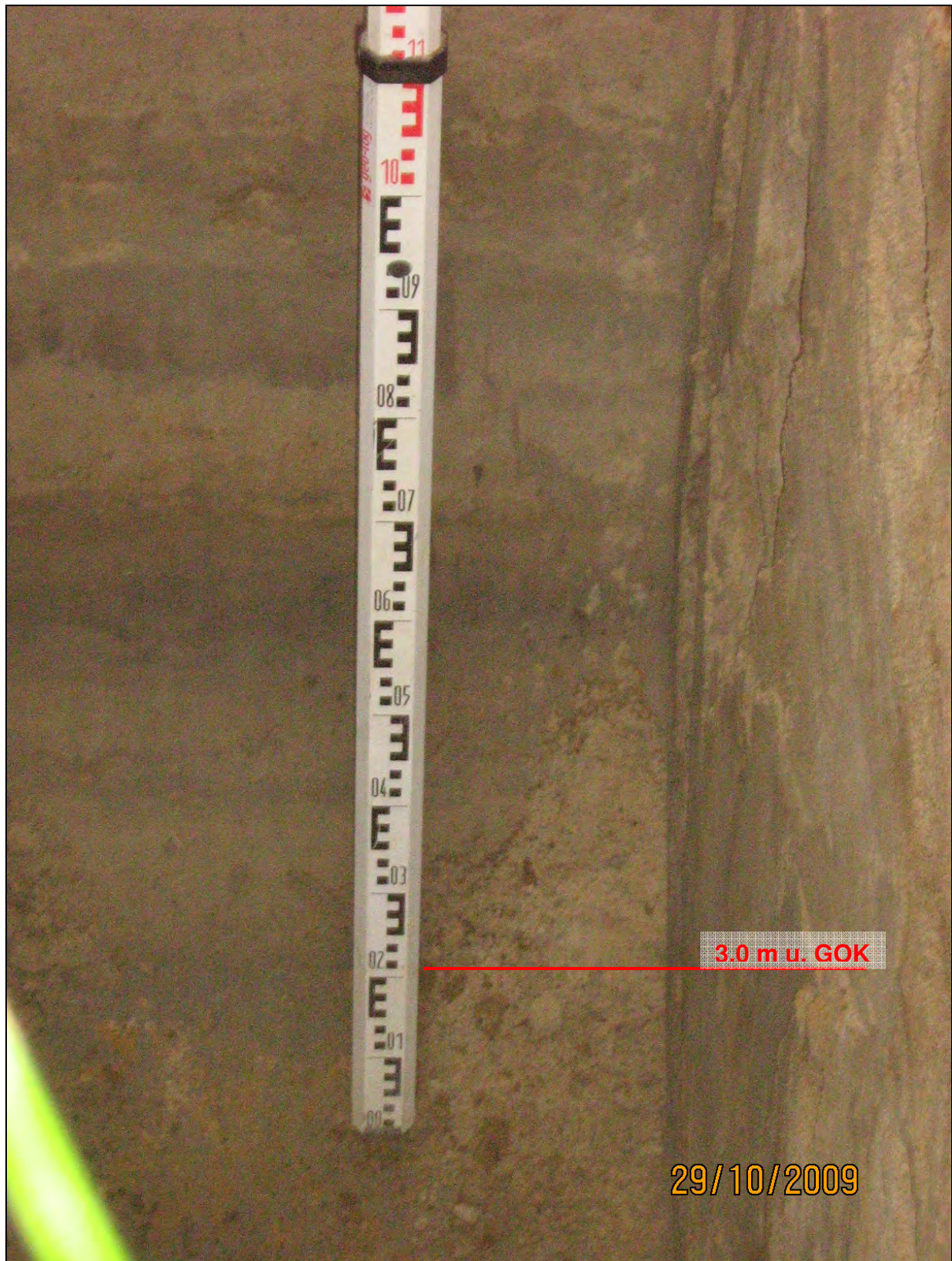
Abbildung 5: Baggerschurf 2,10 bis 3,20 m u. GOK
