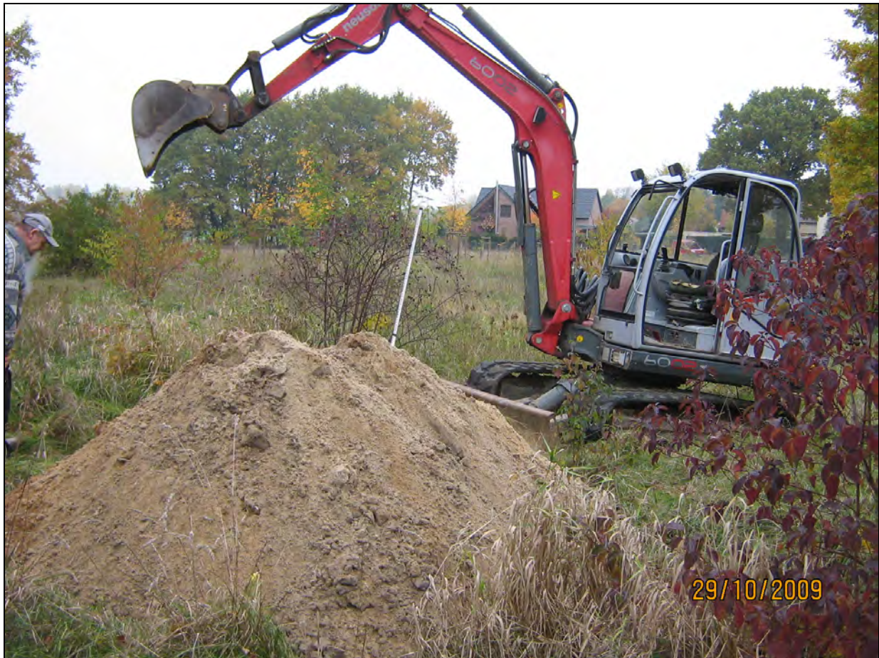
Abbildung 1: Baggerschurf (Westseite der Bahnstrecke)
