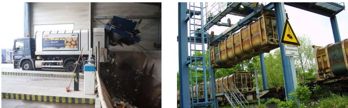
Abbildung 5: Fotos der Restabfallumschlaganlage in Watenbüttel
